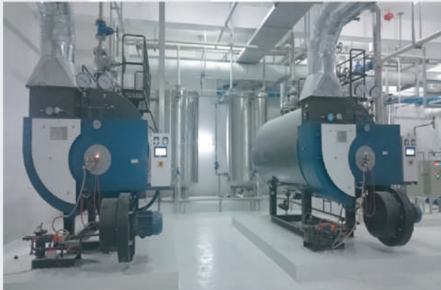
■ LẮP ĐẶT HT LÒ ĐUN NƯỚC NÓNG VÀ ĐƯỜNG ỐNG CẤP NƯỚC NÓNG
