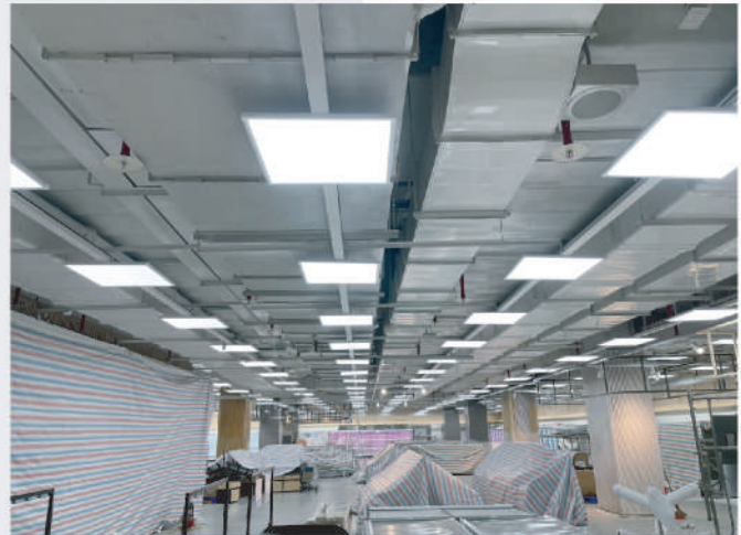
■ LẮP ĐẶT HỆ THỐNG ỐNG GIÓ
