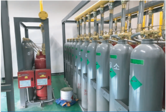
■ LẮP ĐẶT HỆ THỐNG CHỮA CHÁY BẰNG KHÍ FM-200
