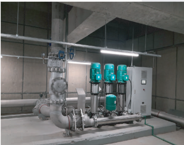
■ LẮP ĐẶT PHÒNG BƠM NƯỚC CẤP
