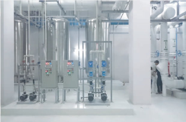
■ LẮP ĐẶT HỆ THỐNG BƠM VÀ TỦ CHO HỆ THỐNG CẤP NƯỚC
