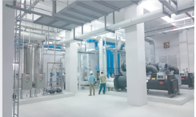
■ LẮP ĐẶT HỆ THỐNG LÀM CHILLER
