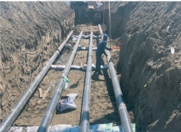
■ LẮP ĐẶT ĐƯỜNG ỐNG NGẦM
